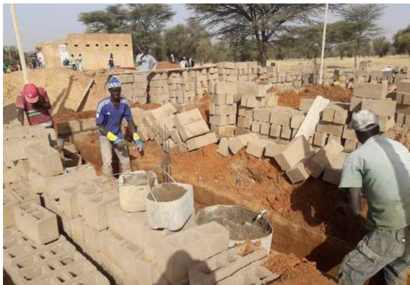
Début de chantier. Photo Bernadette Meury
